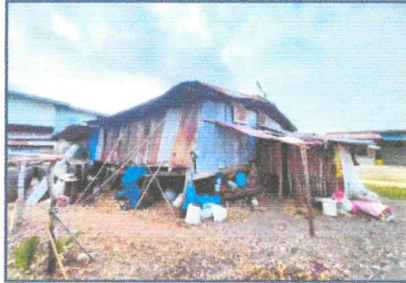
ก่อนดำเนินงาน
