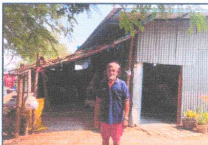
ก่อนดำเนินงาน
