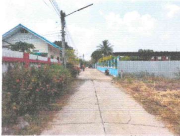
ก่อนดำเนินงาน
