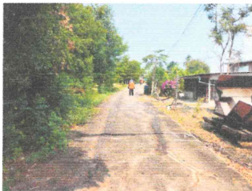
ก่อนดำเนินงาน
