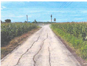
ก่อนดำเนินงาน
