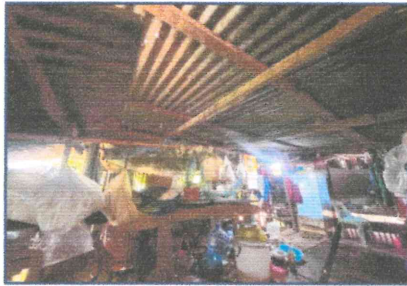
ก่อนดำเนินงาน
